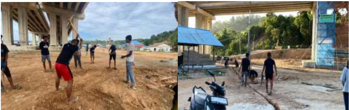
Gambar 2. Pembuatan alur pipa air bersih di Dusun 2 dan 3 Desa Mekar
